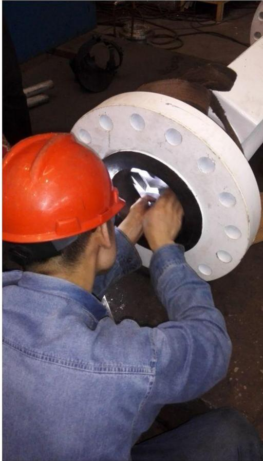
➤ Гидроиспытание статического смесителя.
